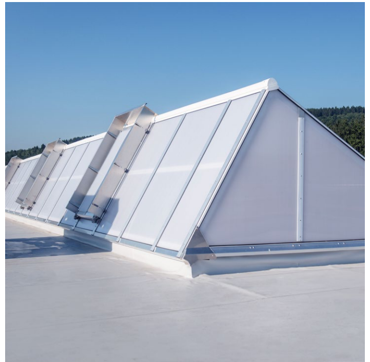
LAMILUX Lichtband S auf der Industriehalle der Kemper GmbH in Olpe
