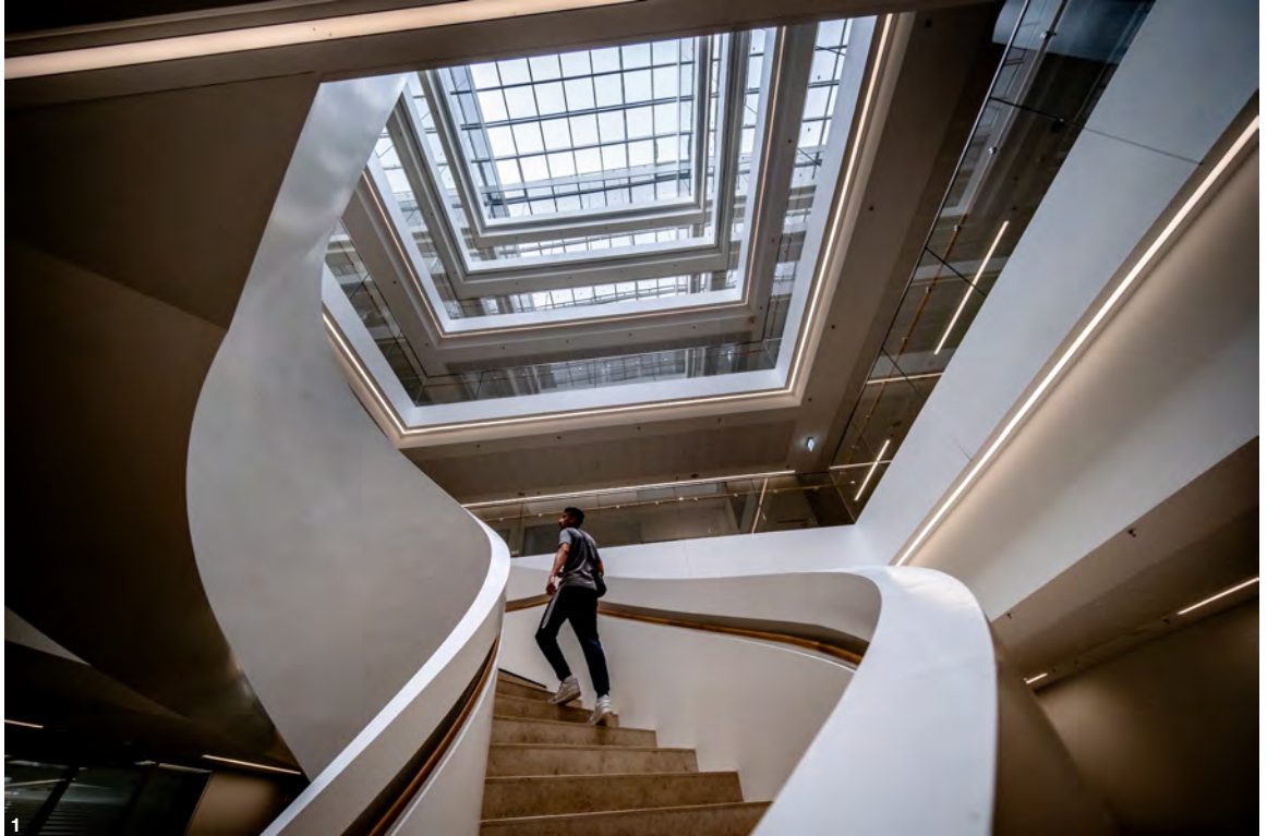
[1] LAMILUX Glasdach PR60 über dem Treppenhaus der Reha-Klinik des Unfallkrankenhauses Berlin
