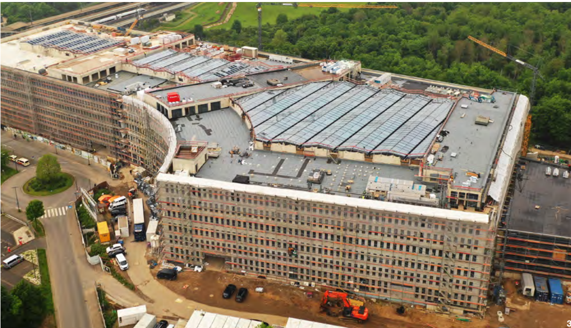
[3] Baustelle des EUREF-Campus Düsseldorf mit verbautem LAMILUX Glasdach PR60 [4] Eventkuppel im EUREF Campus Düsseldorf
