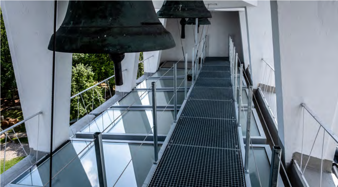
Kirchturmglöcken über den sanierten LAMILUX Flachdach Fenstern der Paulus Kirche in Traunreuth
