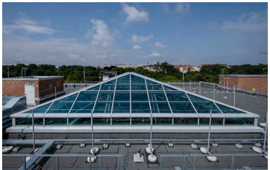
Saniertes LAMILUX Glasdach PR60 auf dem Dante Gymnasium in München
