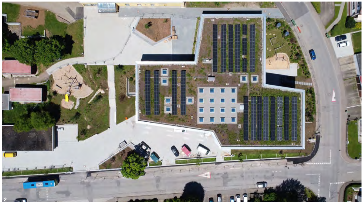
[1] Außenansicht des Neubaus [2] Photovoltaikanlage und LAMILUX Flachdach Fenster auf dem Flachdach des Neubaus des Schulcampus Blumberg
