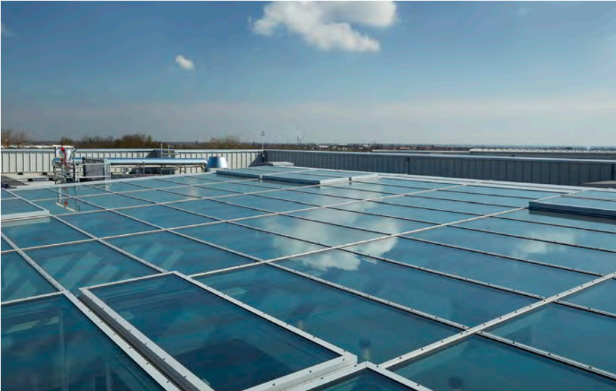
LAMILUX Glasdach PR60 auf dem Flachdach von „Brittish Sugar“, England
