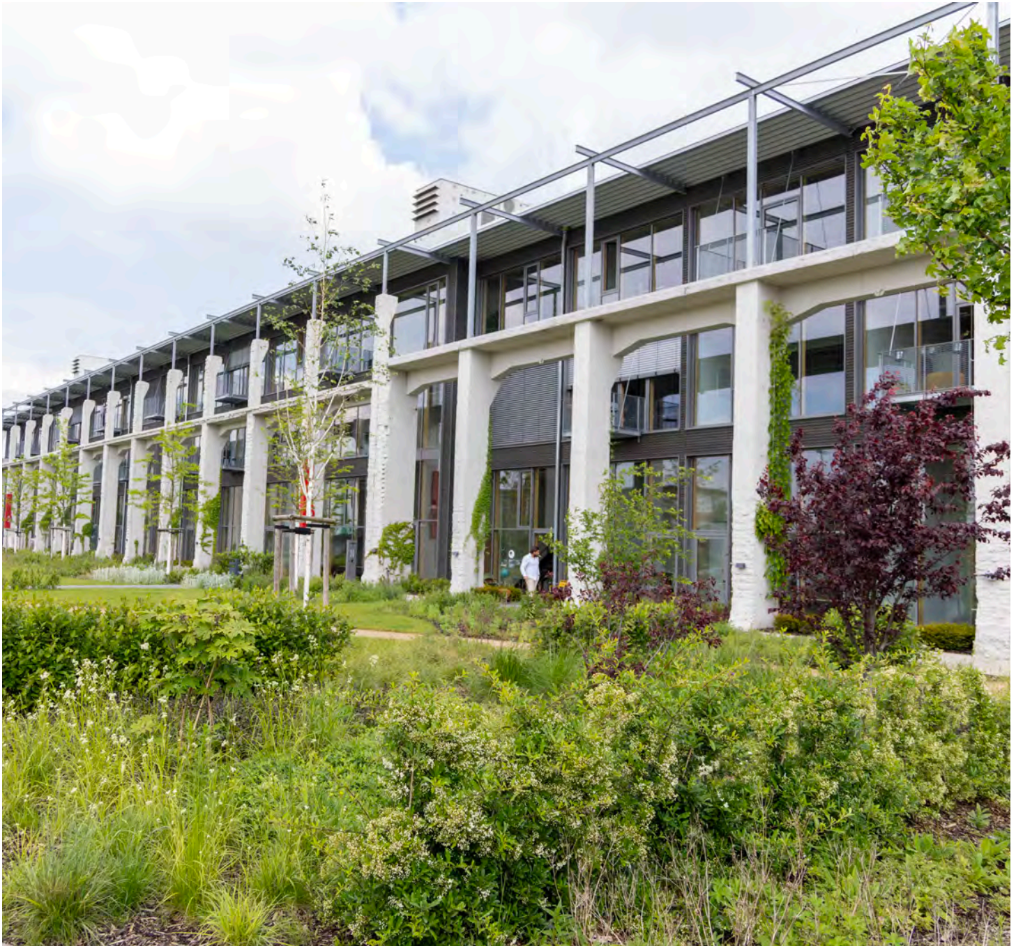
Außenansicht des Arkadengebäudes des Factory Campus Düsseldorf
