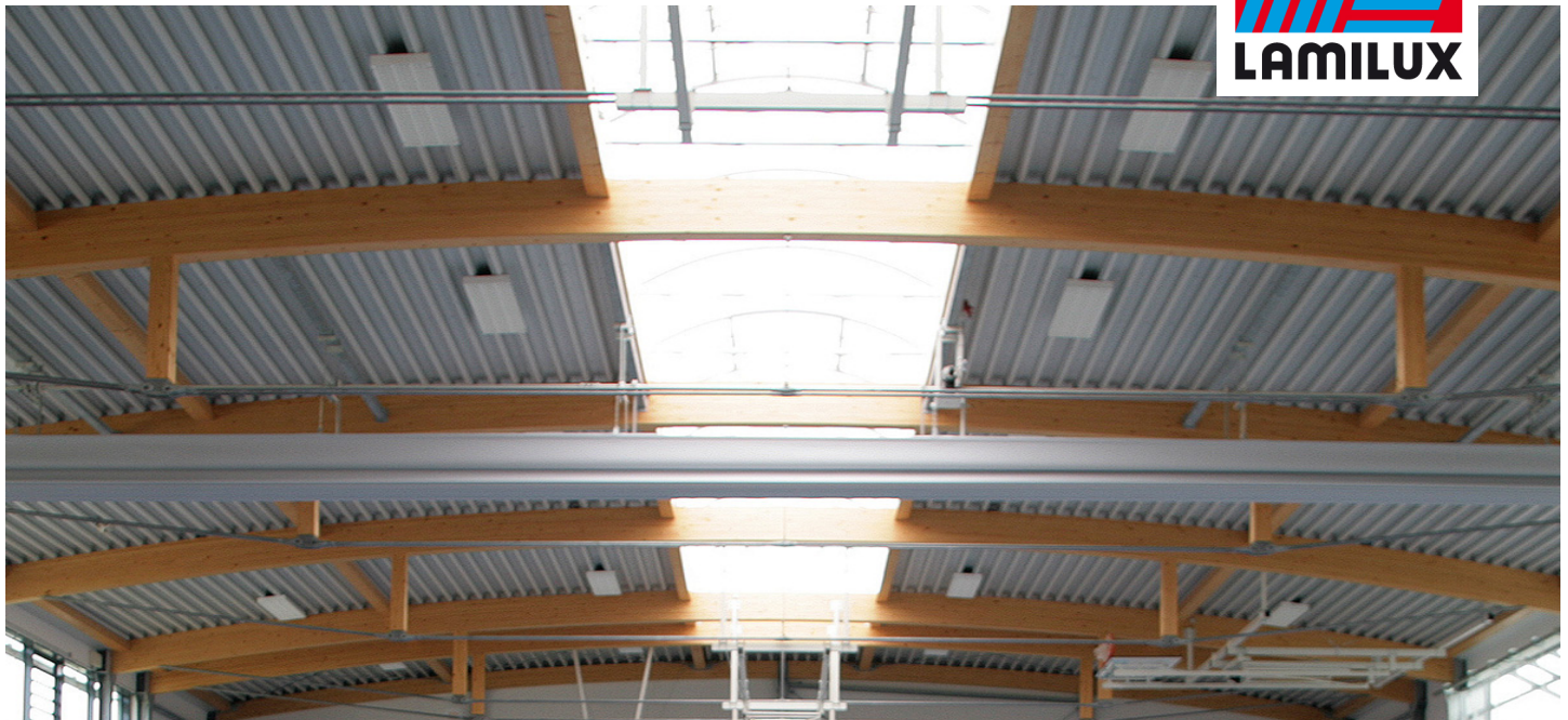
Sporthalle Mittelschule Adorf
